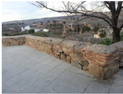
Paseo Recaredo//Puente San Martín
